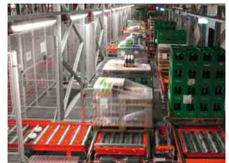
4 Nach Abruf einer Tour werden die Kundenaufträge automatisch ausgelagert und über die Fördertechnik zu den 17 Schwerkraftrollbahnen transportiert
