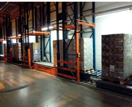
Ersetzte Einlagerstichbahn im Tiefkühl-lager (-26 °C)
