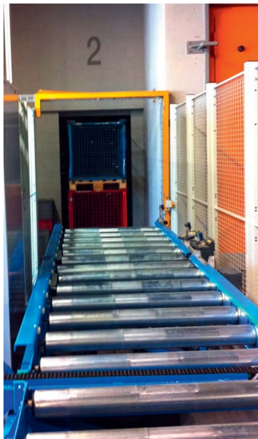
③ + ④ Alte Hubantriebs- einheiten der Paletten- aufzüge (Bild links) wurden mit neuen Schneckengetriebe- motoren mit Inkre- mentalgebern und Sicherheitsbremsen ausgerüstet
