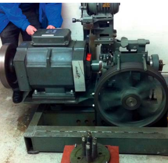
1 + 2 Durch die Erneuerung der Steuerungstechnik sowie der Antriebs- und Positioniersysteme (Bild rechts) konnten die Betriebssicherheit verbessert und die Anlagenverfügbarkeit deutlich erhöht werden
