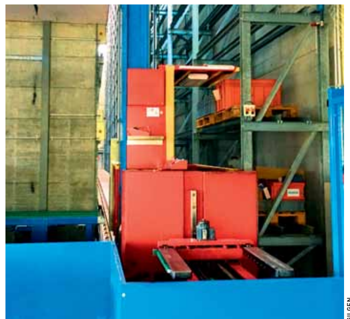
Die Steuerungs- und Sicherheitstechnik der Paletten-Hochregalanlage entsprechen nun dem heutigen Stand der Technik.
