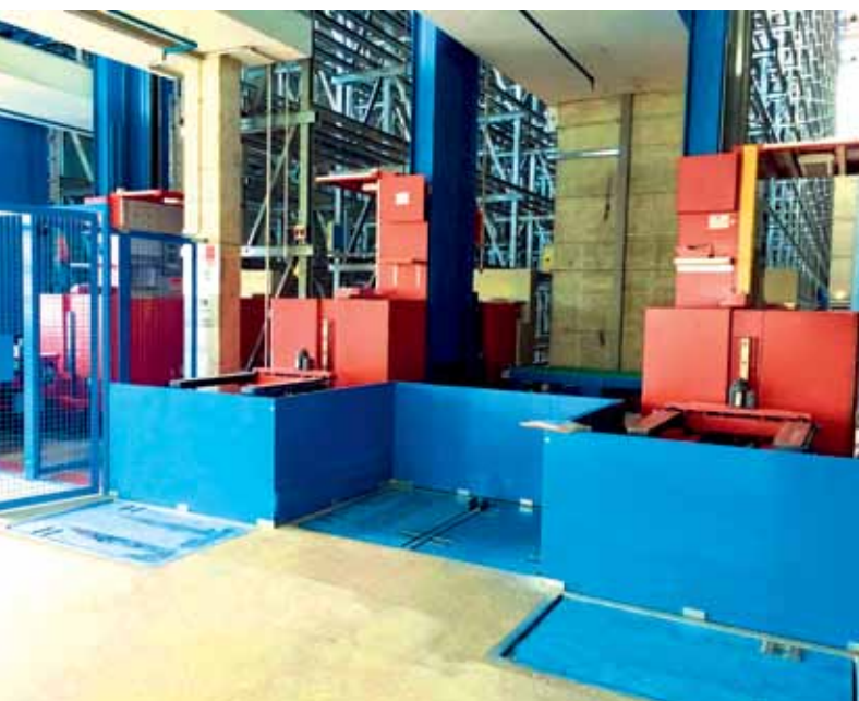
Durch die Modernisierungsmaßnahmen können die vier Regalbediengeräte nun auch halbautomatisch betrieben werden.
