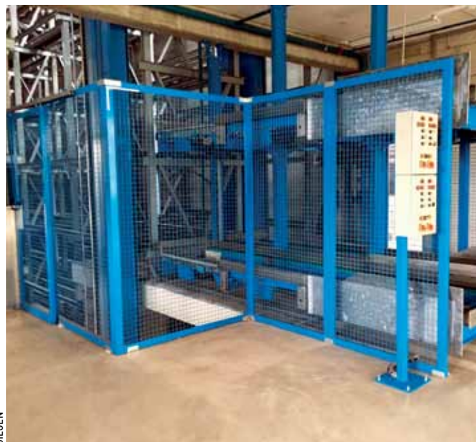
Die Personensicherheit wurde durch zusätzliche mechanische Maßnahmen wie Gitter, Netze und Warntafeln erhöht.
