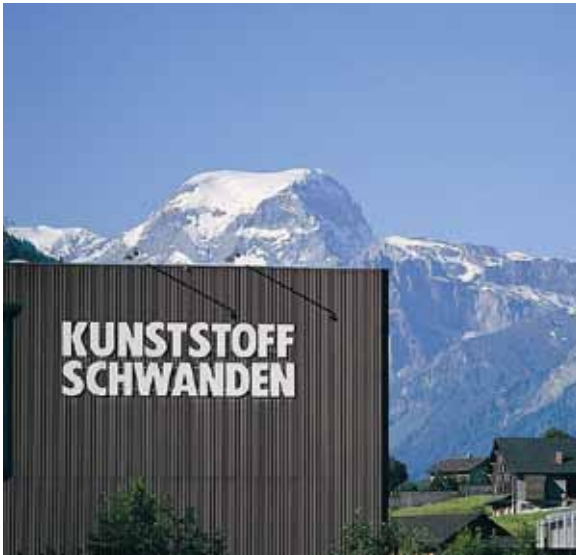
Aussenansicht des Hochregallagers mit seinen 18 000 Palettenplätzen. (Bild: Kunststoff Schwanden AG)
