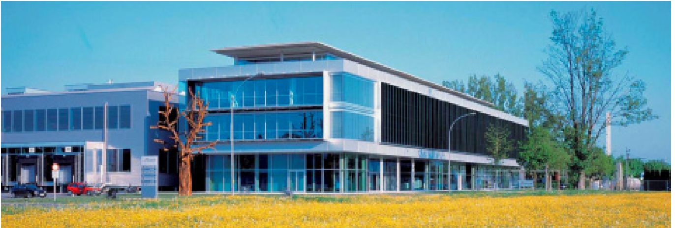
Das neue Zentralgebäude der Walter Bösch KG im Industriegebiet Nord in Lustenau.
