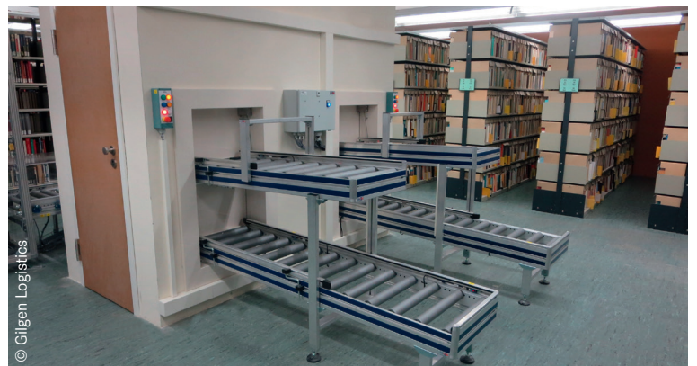
Das automatische Medienfördersystem verbindet die Magazinbereiche mit der Ausleihe, der Buchrückgabe und der Poststelle.
