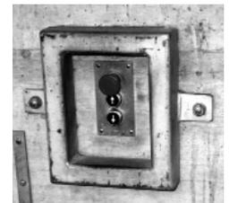
Eingemauerte oder mit einem robusten Rahmen versehene Bedienungsorgane sind gegen das Anfahren von Fahrzeugen geschützt.
