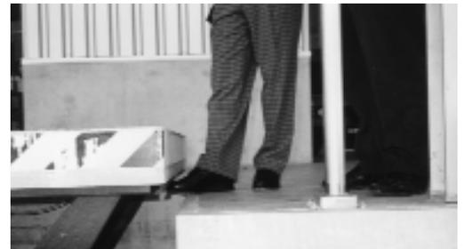
Kontaktleisten verhindern zum Beispiel, dass ein Fuss eingeklemmt wird.
