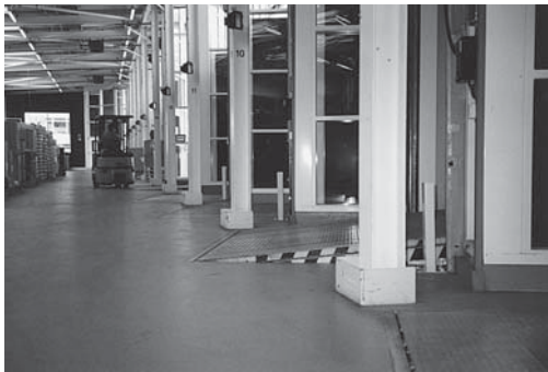
Bild 4: Angehobene Rampen stellen eine Stolpergefahr dar. Die seitliche Markierung macht auf diese Gefahr aufmerksam.
