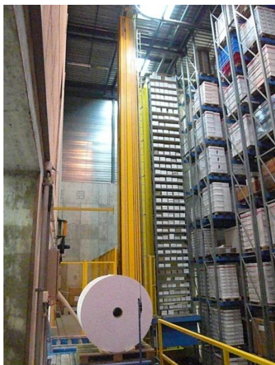
Durch die Erweiterung des Hochregallagers verfügen nun sämtliche Lagergänge über ein eigenes Regalbediengerät.
